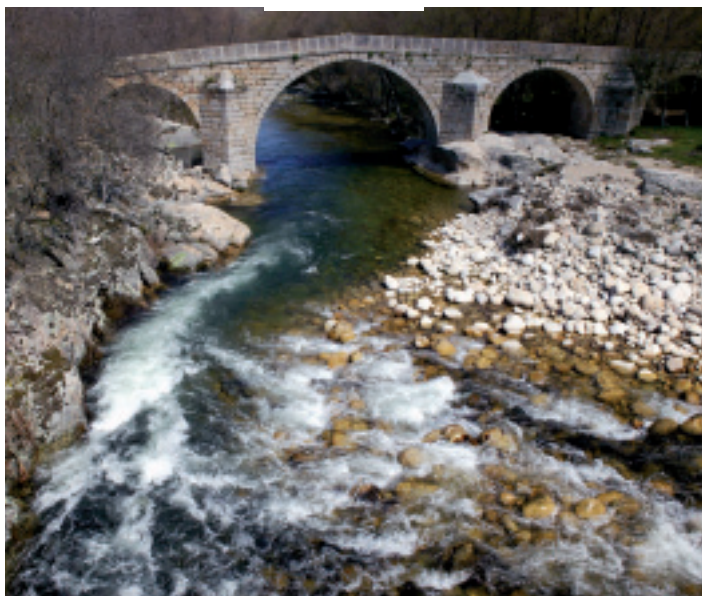
Puente de Tormellas sobre la garganta de los Caballeros
