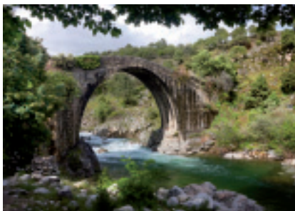
Puente garganta de Alardos
