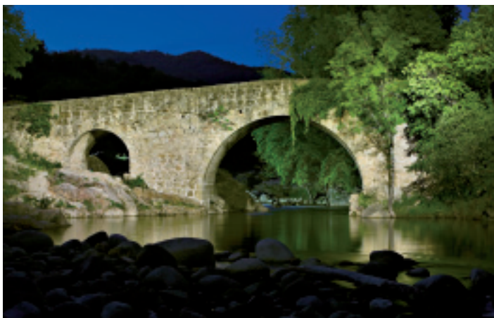
Puente sobre la garganta de Cuartos
