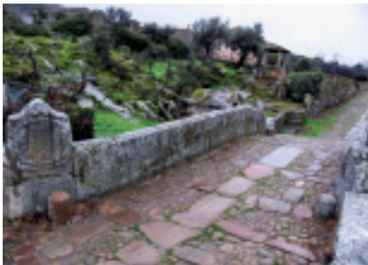
Puente de piedra sobre el barranco de la Oliva
