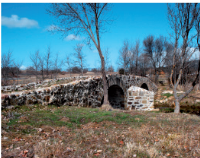
Puente de piedra en el camino
