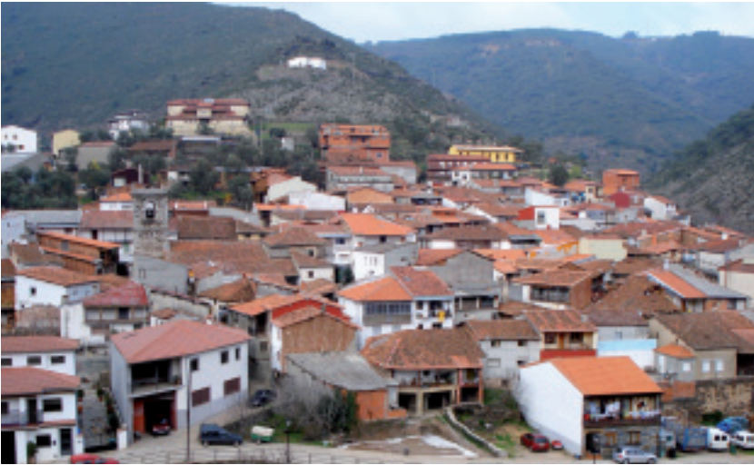
Valero. Vista general
