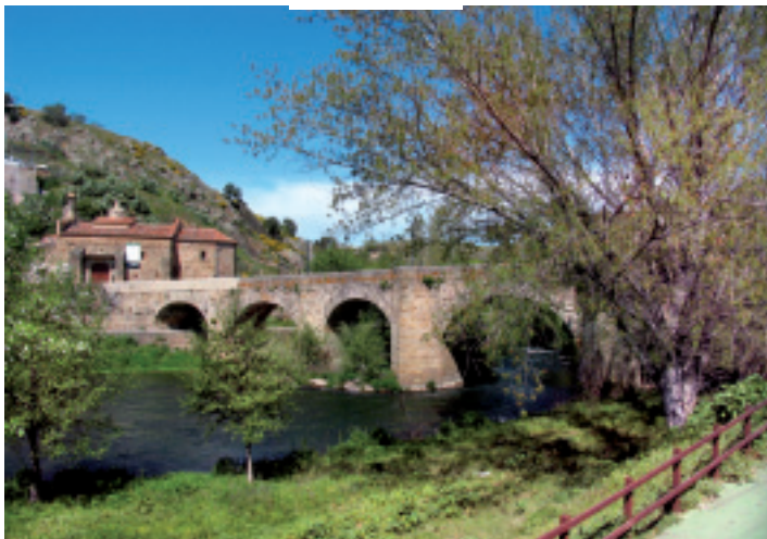
Puente de San Lázaro. Plasencia
