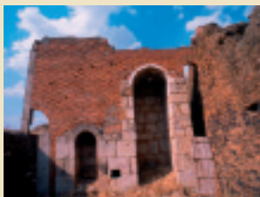
Antiguas instalaciones mineras
